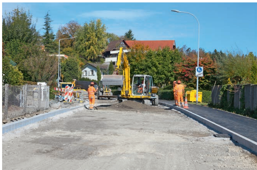
Baustelle Adligenswilerstrasse, Abschnitt Obermatt bis Tschädigen: Die Gemeinde Meggen investierte auch im Jahr 2019 in die Infrastruktur.
