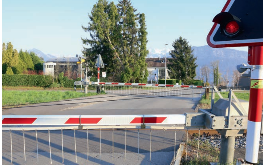
Geschlossene Barrieren, ein Zug naht – der Bahnübergang Huobstrasse.
