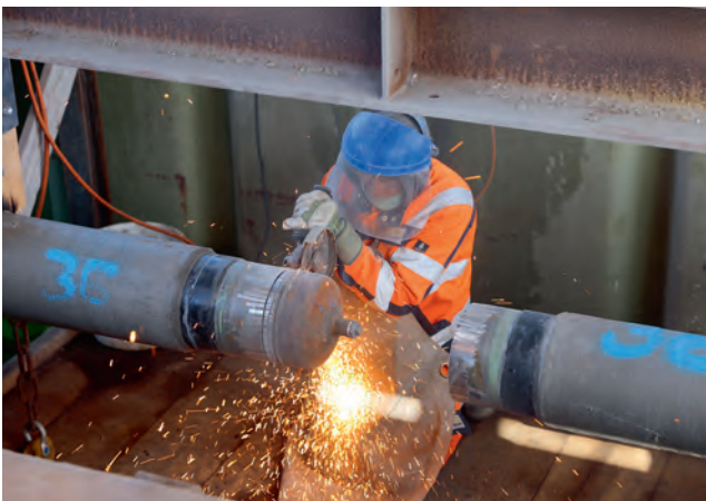
Präzisionsarbeit auf der Arbeitsplattform beim Zusammensetzen der Rohre.
