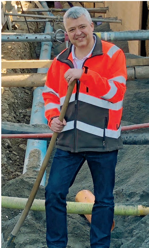
Projektleiter Arnel Bösch im Bereich der Baustelle Siegwartstrasse in Küssnacht. Direkt links von ihm ist die neue Megger Transportwasserleitung (blaues Rohr) zu erkennen.
