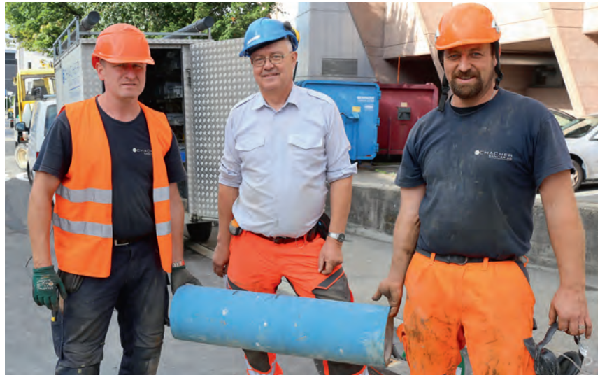
Der historische Moment: Brunnenmeister-Stellvertreter Jakob Kälin (Mitte) und die beiden Mitarbeiter von Schacher Sanitär, Jens Paulick (links) und Peter Achermann (rechts), präsentieren das letzte Verbindungsstück, welches in Küssnacht eingesetzt wurde.
