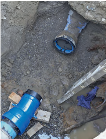
Diese Lücke – das Verbindungsstück zwischen einer alten und einer neuen Leitung – musste noch geschlossen werden.
