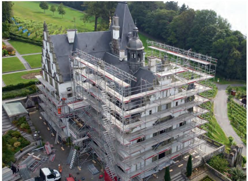
Dienstag, 7. September 2021: Schloss Meggenhorn wird eingerüstet.
