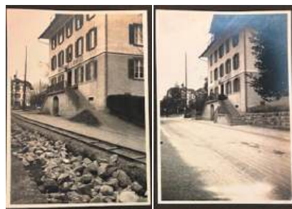
Strassensanierung 1920 beim Restaurant Kreuz, hist. Archiv Meggen.
