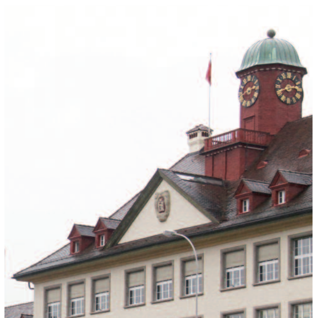
Beim Zentralschulhaus wird die Turmuhr saniert.
