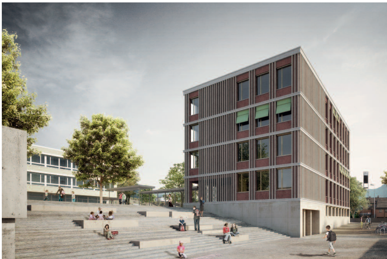
Mit der Sanierung und Erweiterung des Schulzentrums Hofmatt legt die Gemeinde einen Meilenstein für die Zukunft der Bildung.
