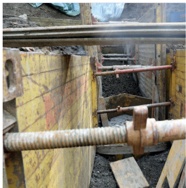
Im Quellgebiet Lauerz werden weitere Quellfassungen erneuert.
