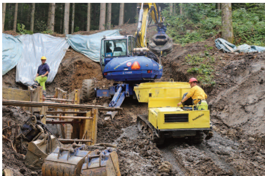
Sanierungsarbeiten im Bereich der Quellschneisen der Wasserversorgung Meggen am Lauerzberg im Kanton Schwyz.
