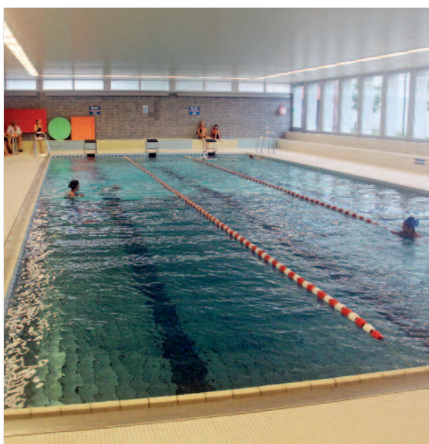
Im Hallenbad soll der Hubboden saniert werden.
